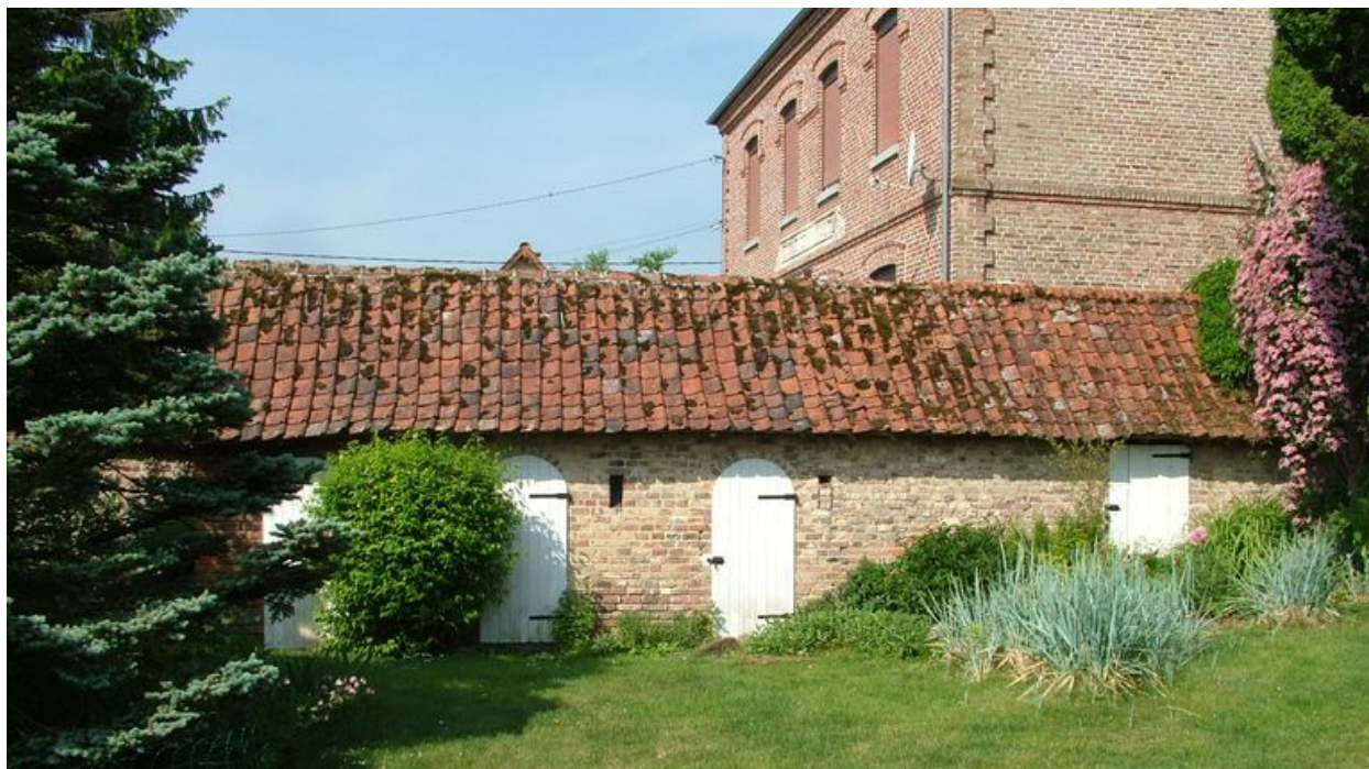
Ancienne étable, 18 rue d'En-Haut, 2e moitié du 19e siècle.
