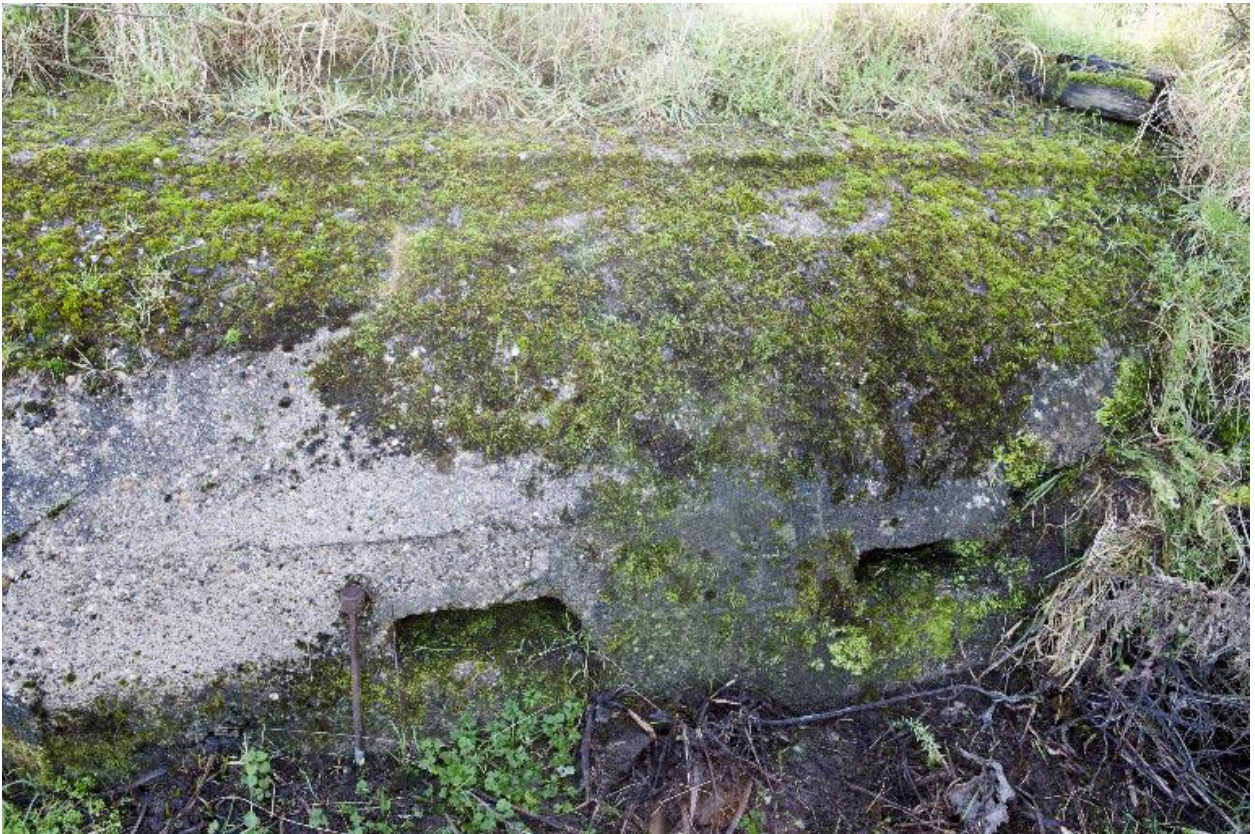
Casemate A : Créneaux de fusillade ou d'observation sur l'élévation nord-ouest
