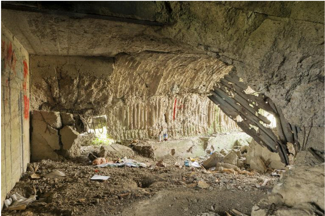
Edifice b. Vue intérieure depuis l'entrée
