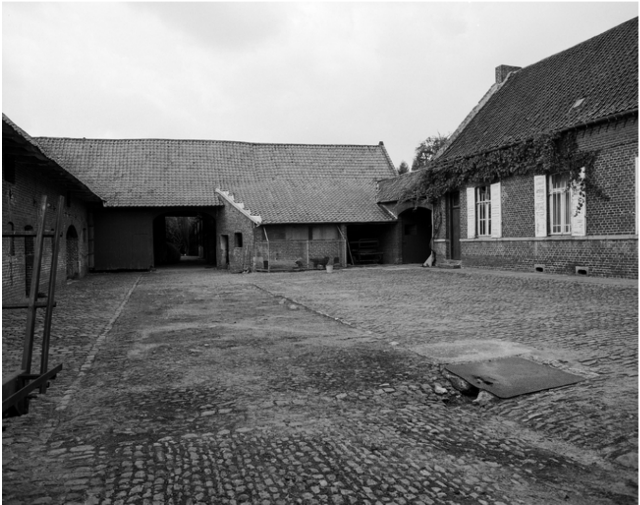
La cour : le logis (à droite), les communs (à gauche), la grange (au fond).
