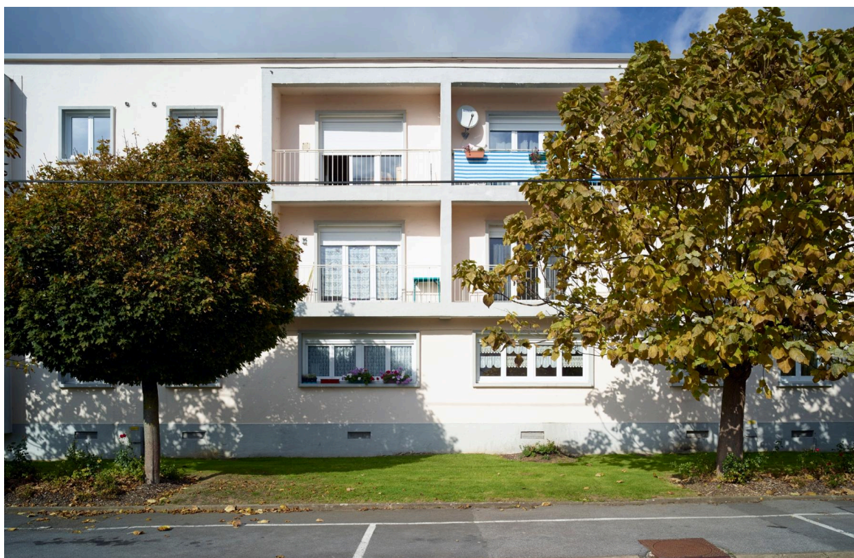
Vue du bloc A côté rue.
