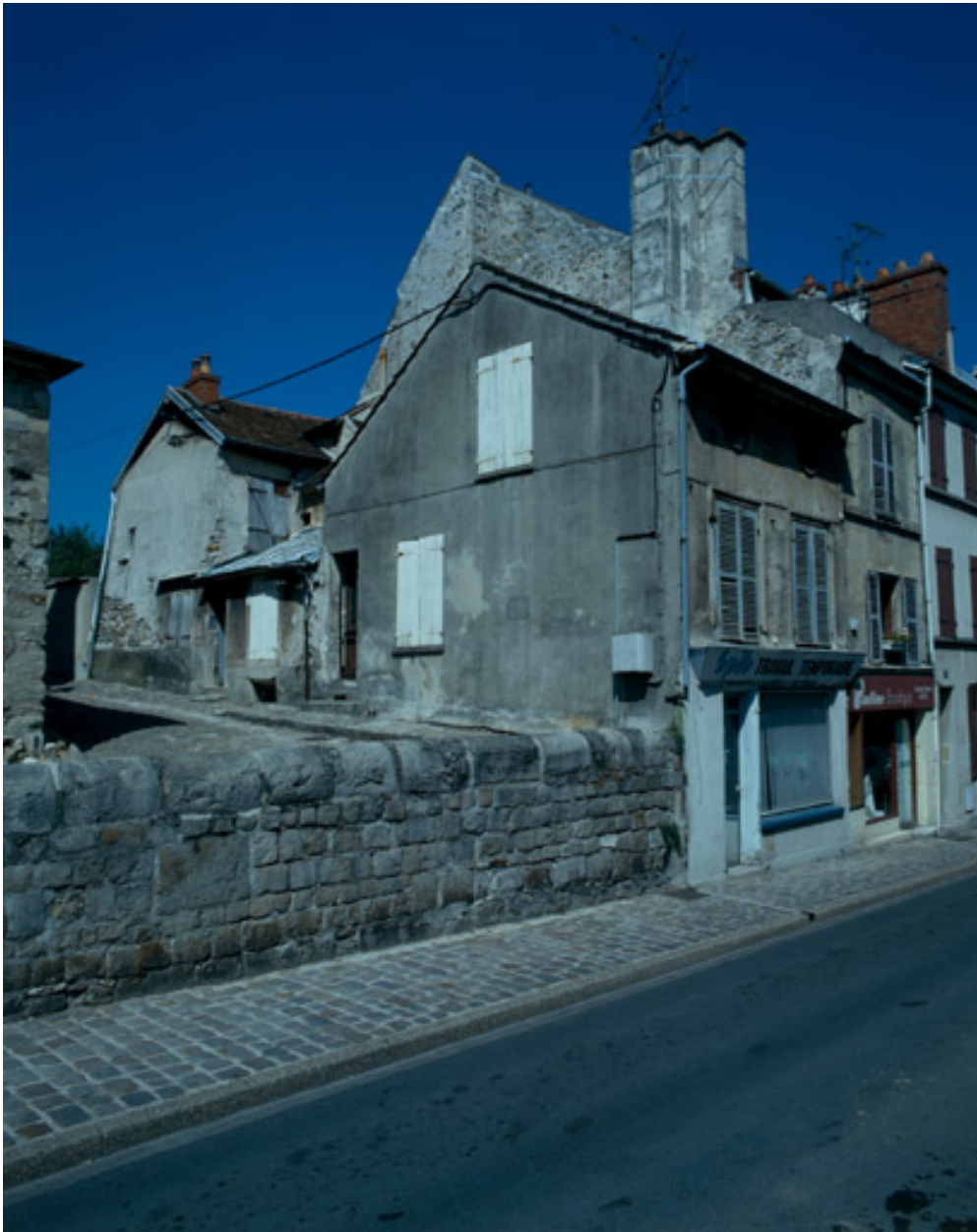
Vue d'ensemble depuis la rue.
