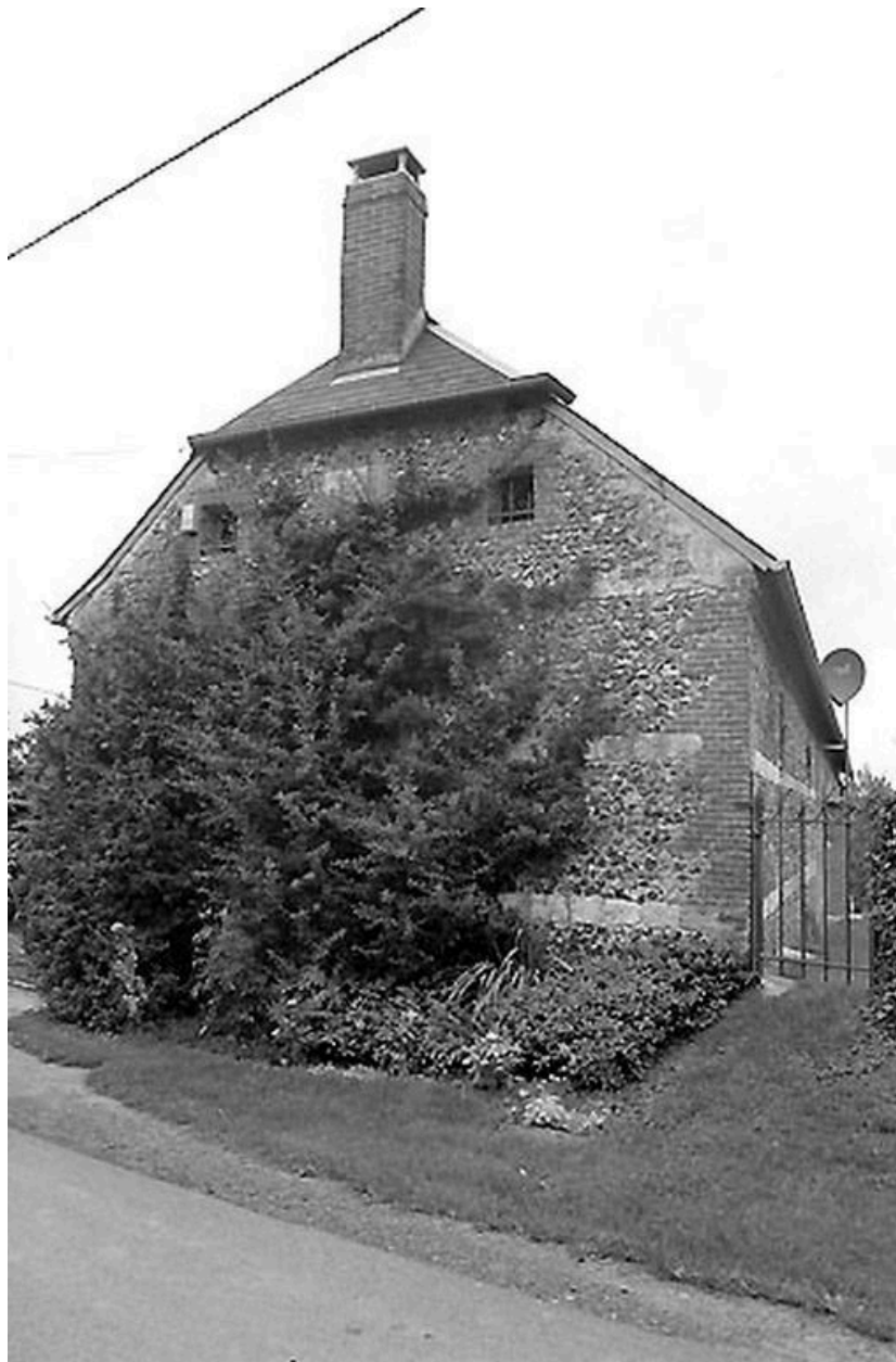
Vue générale du mur pignon du logis.
