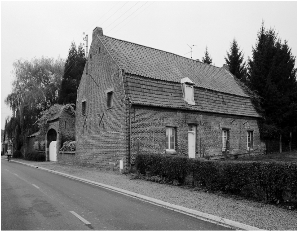
Ferme, 81, rue Molière, le logis.
