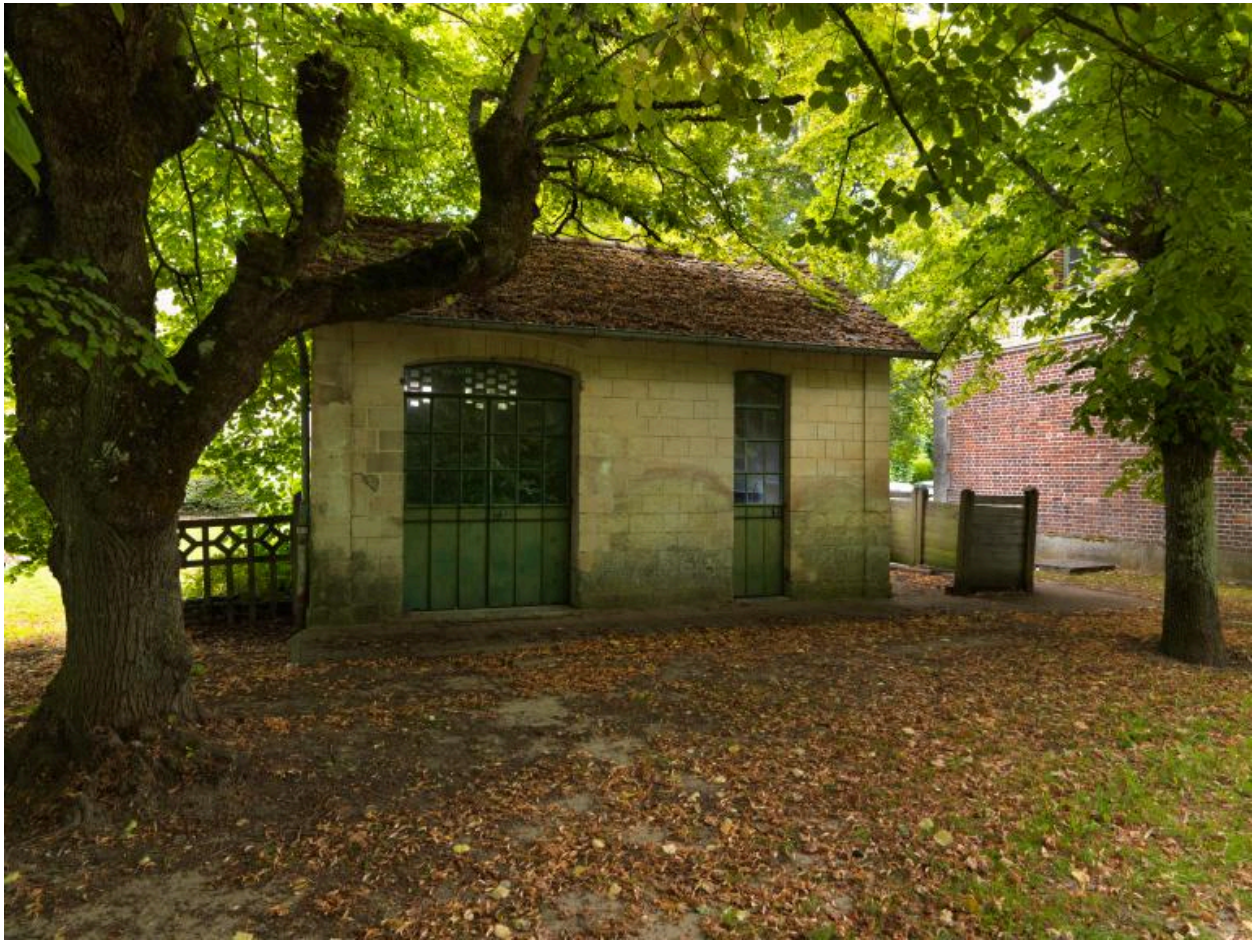
Pavillon de lampisterie à l'ouest du bâtiment des voyageurs, aujourd'hui local poubelles.
