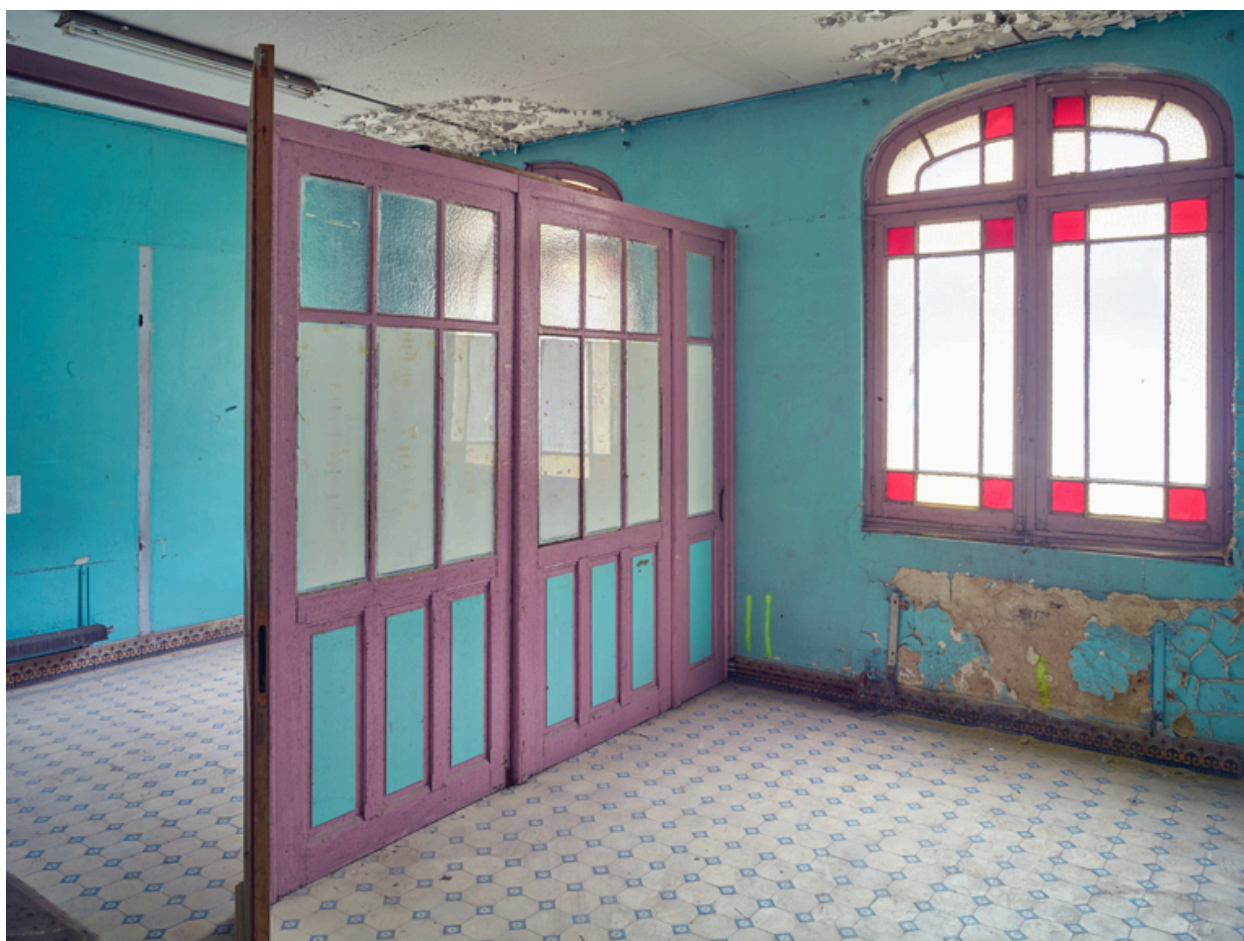
Bâtiment central, rez-de-chaussée. Vue du salon de coiffure et du bureau.
