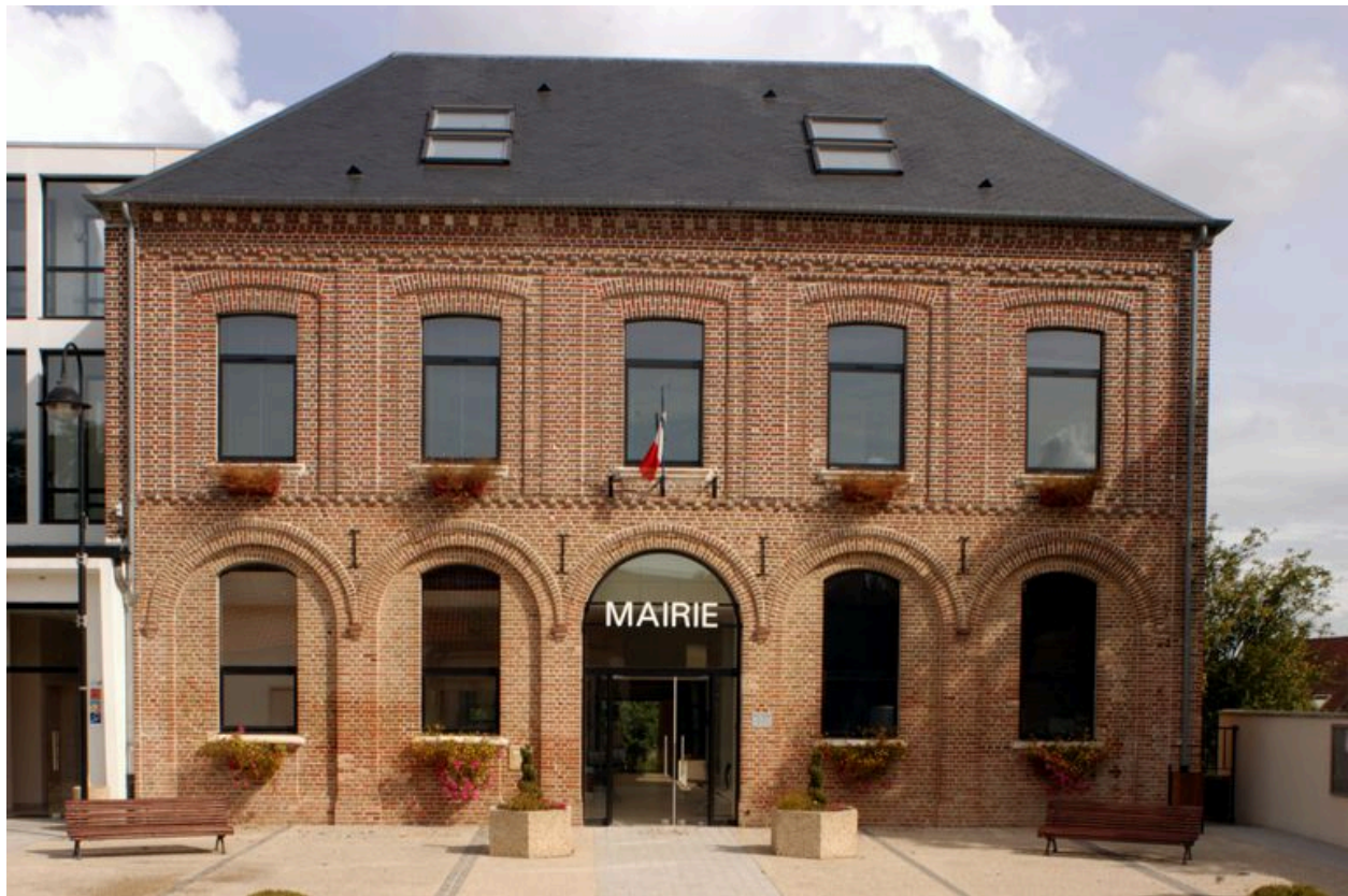
Vue de la façade sud.
