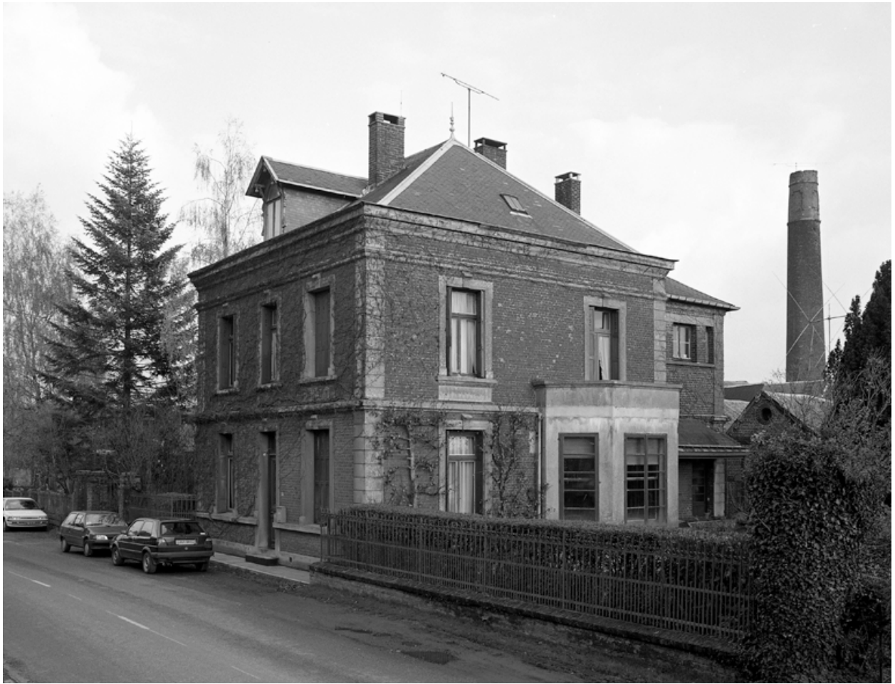
Vue générale du logement patronal.
