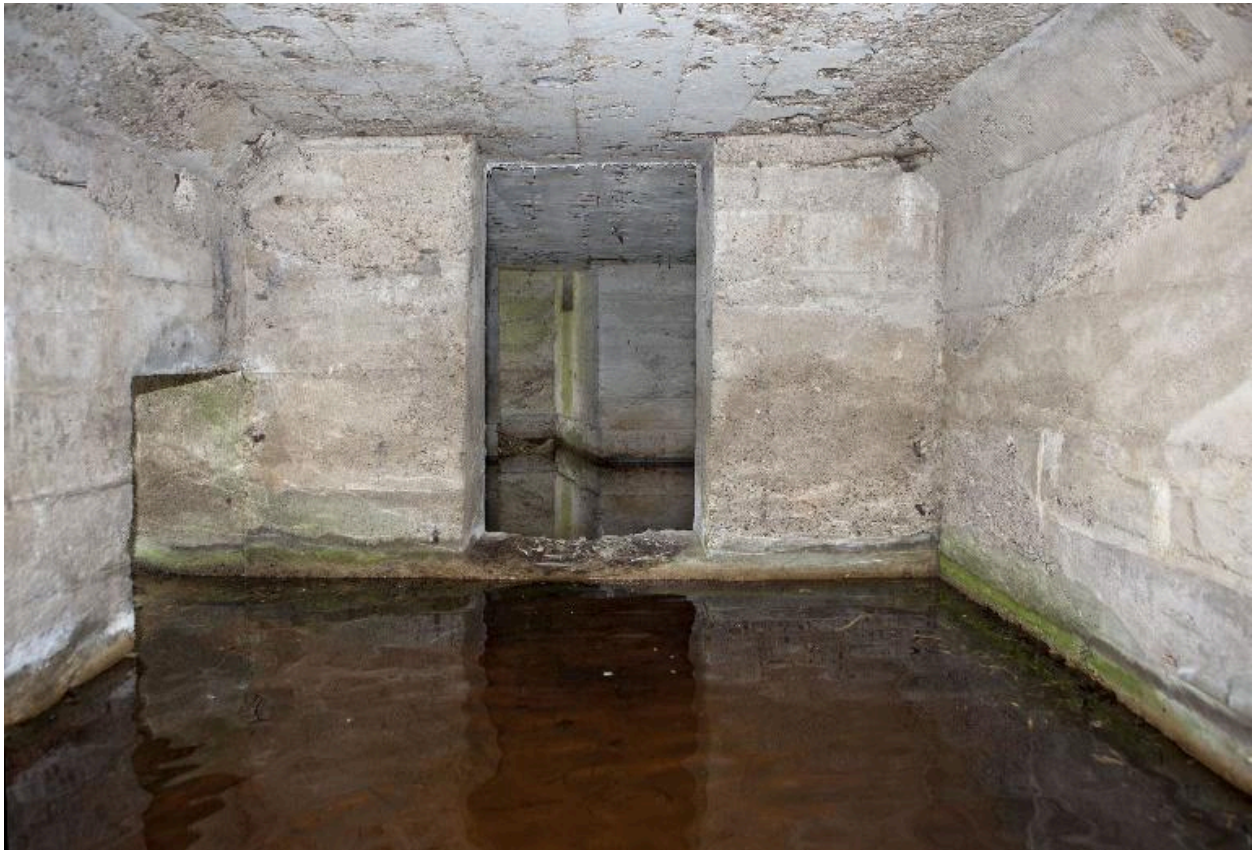
L'intérieur vers le sud ouest. A gauche le débouché de la resserre à mitrailleuse
