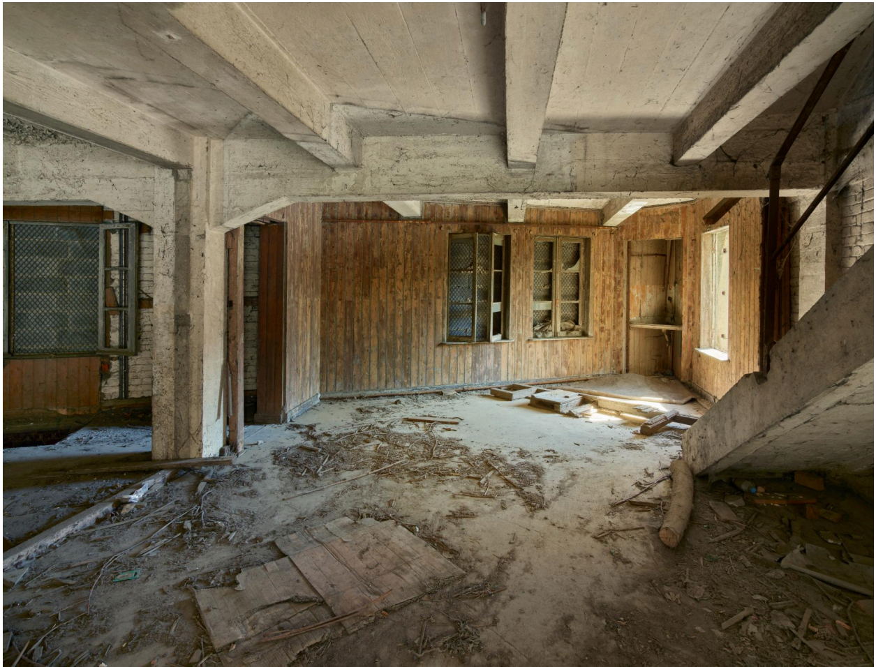
Vue intérieure du premier étage de la minoterie.
