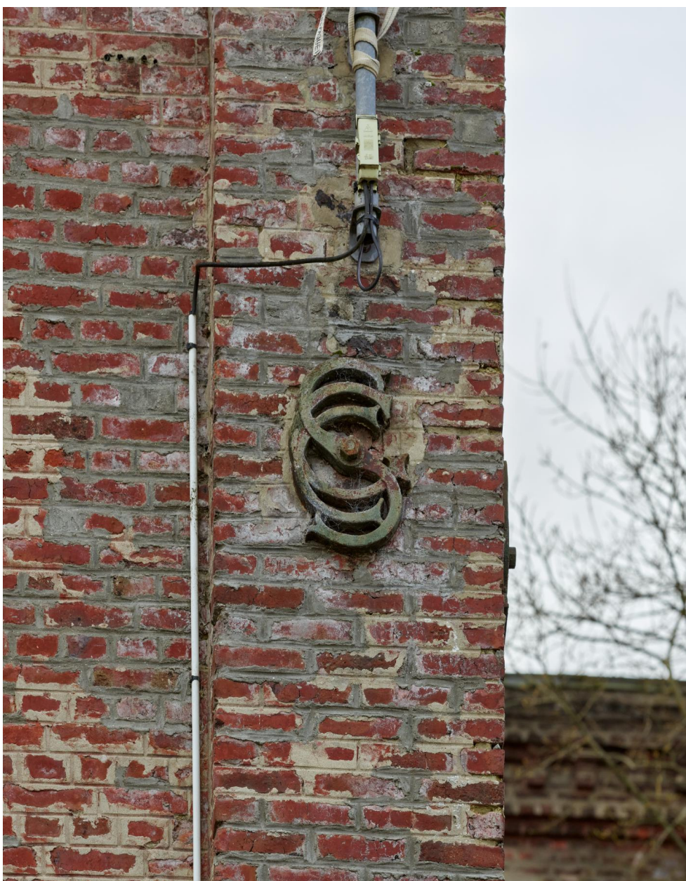
Détail d'un fer d'ancrage portant les initiales entrelacées CS.
