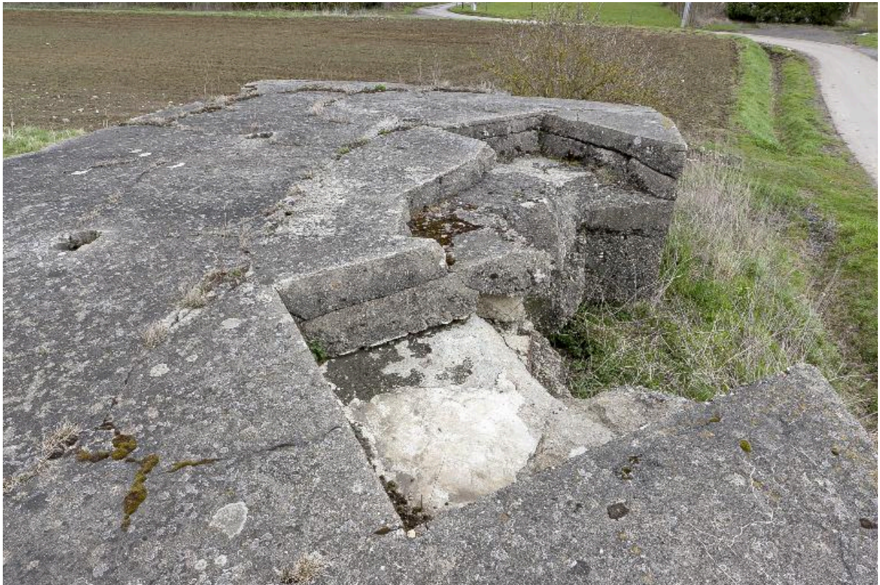
Depuis le toit, vue des logements d'armes
