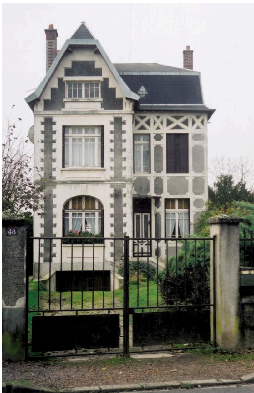
Maison, 48 rue Joliot-Curie.
