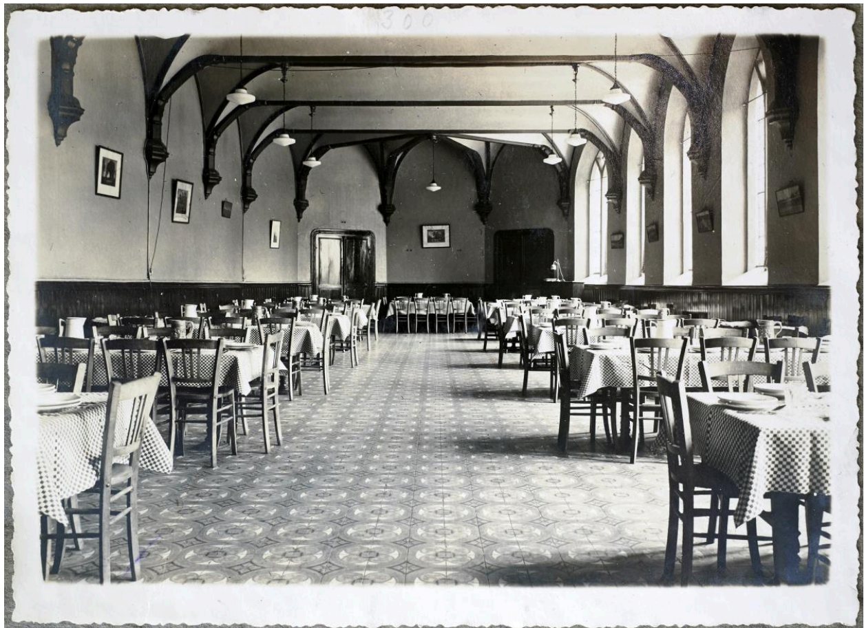
Vue du réfectoire (rez-de-chaussée de la chapelle) et du sol de carreaux de ciment, vers 1904.
