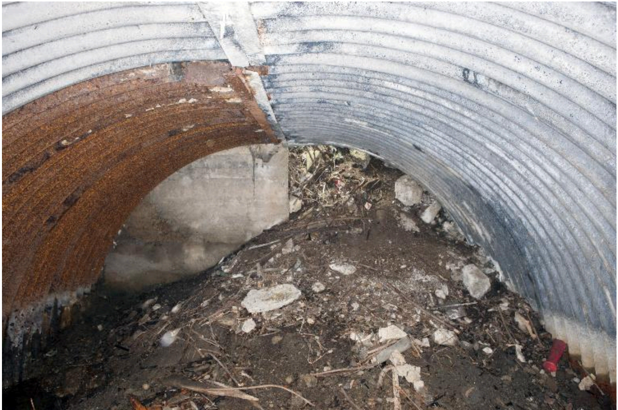
Casemate A. Salle perpendiculaire au couloir. Au fond : accès au poste de mitrailleuse (?)
