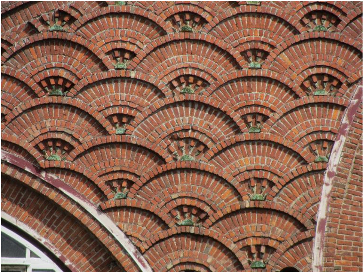
Détail de l'appareillage de brique de la façade du laboratoire.
