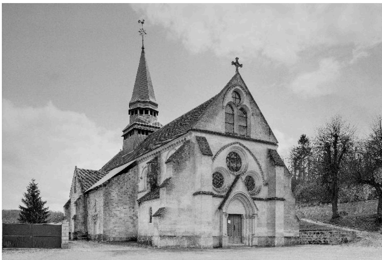
Vue générale de l'église, depuis le nord-ouest.
