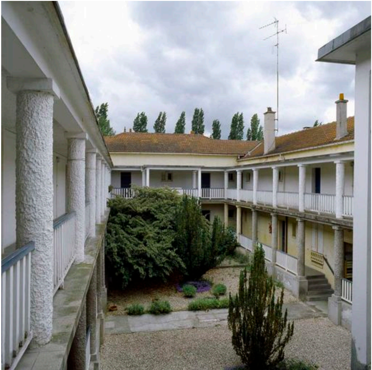
Bâtiment 520 : Vue générale de la cour intérieure.
