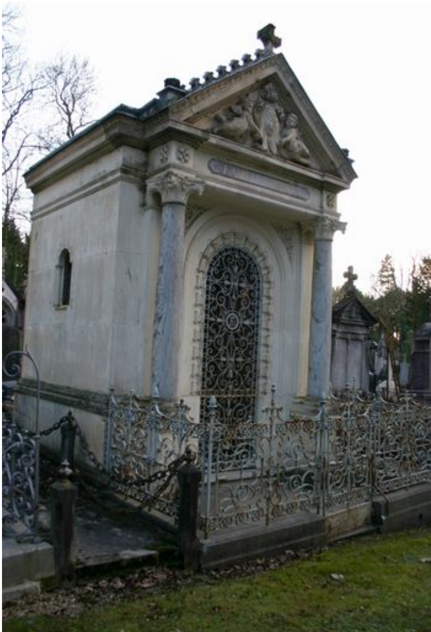
Vue générale, depuis le côté.
