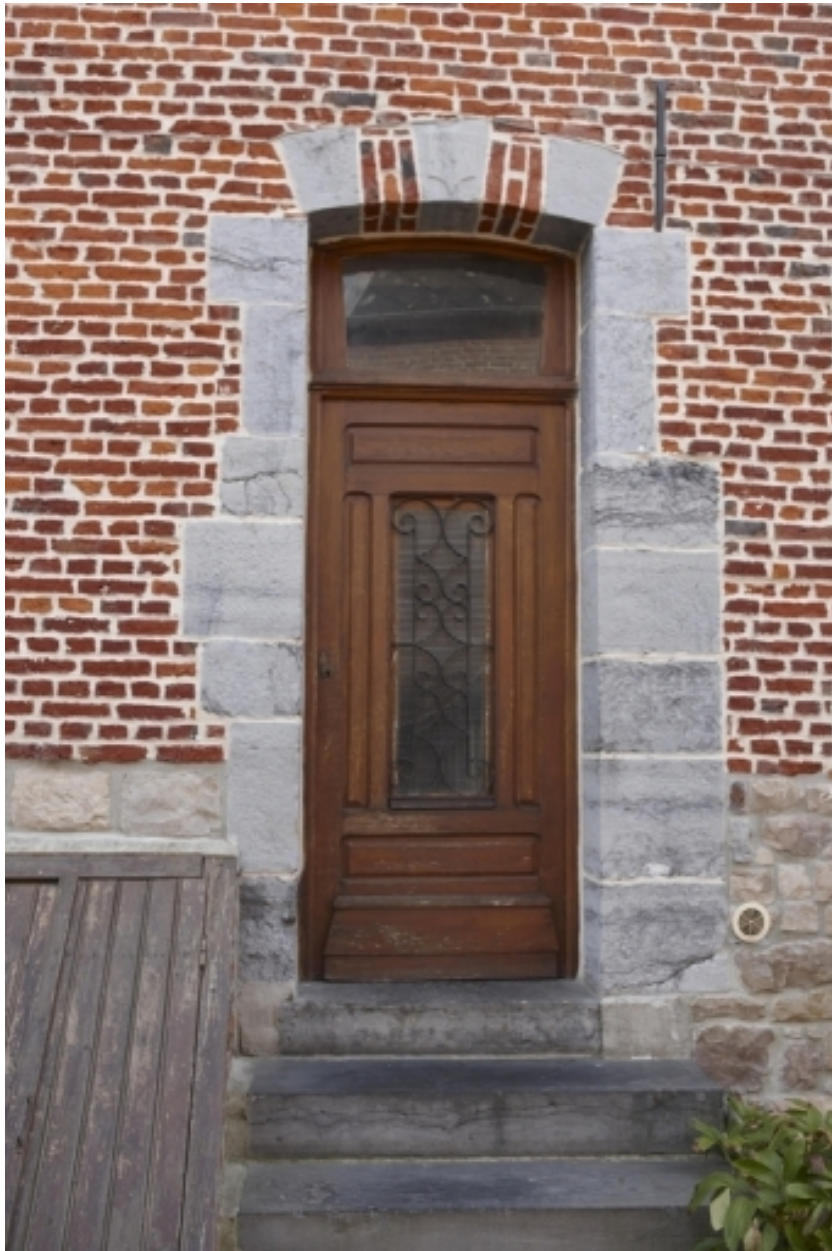
Détail de la porte du logis.
