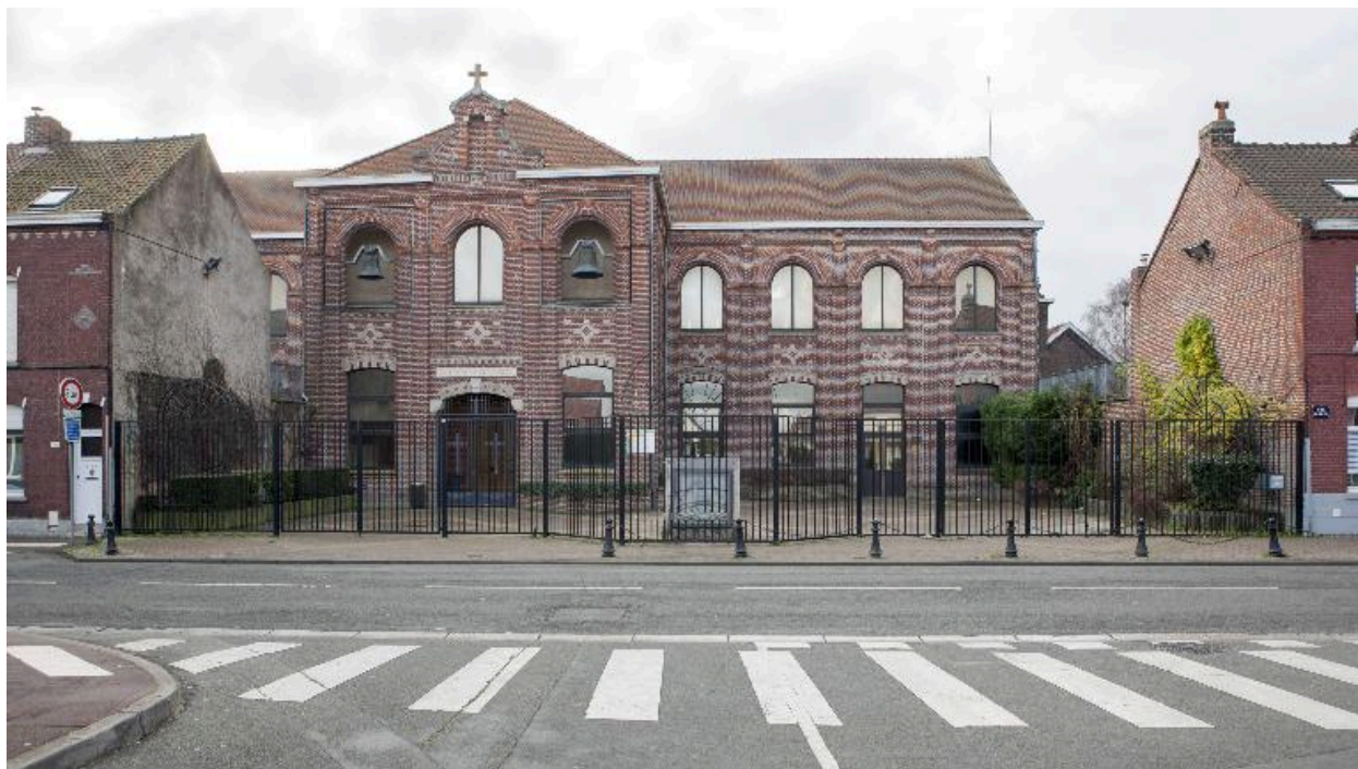
Élévation antérieure de la chapelle
