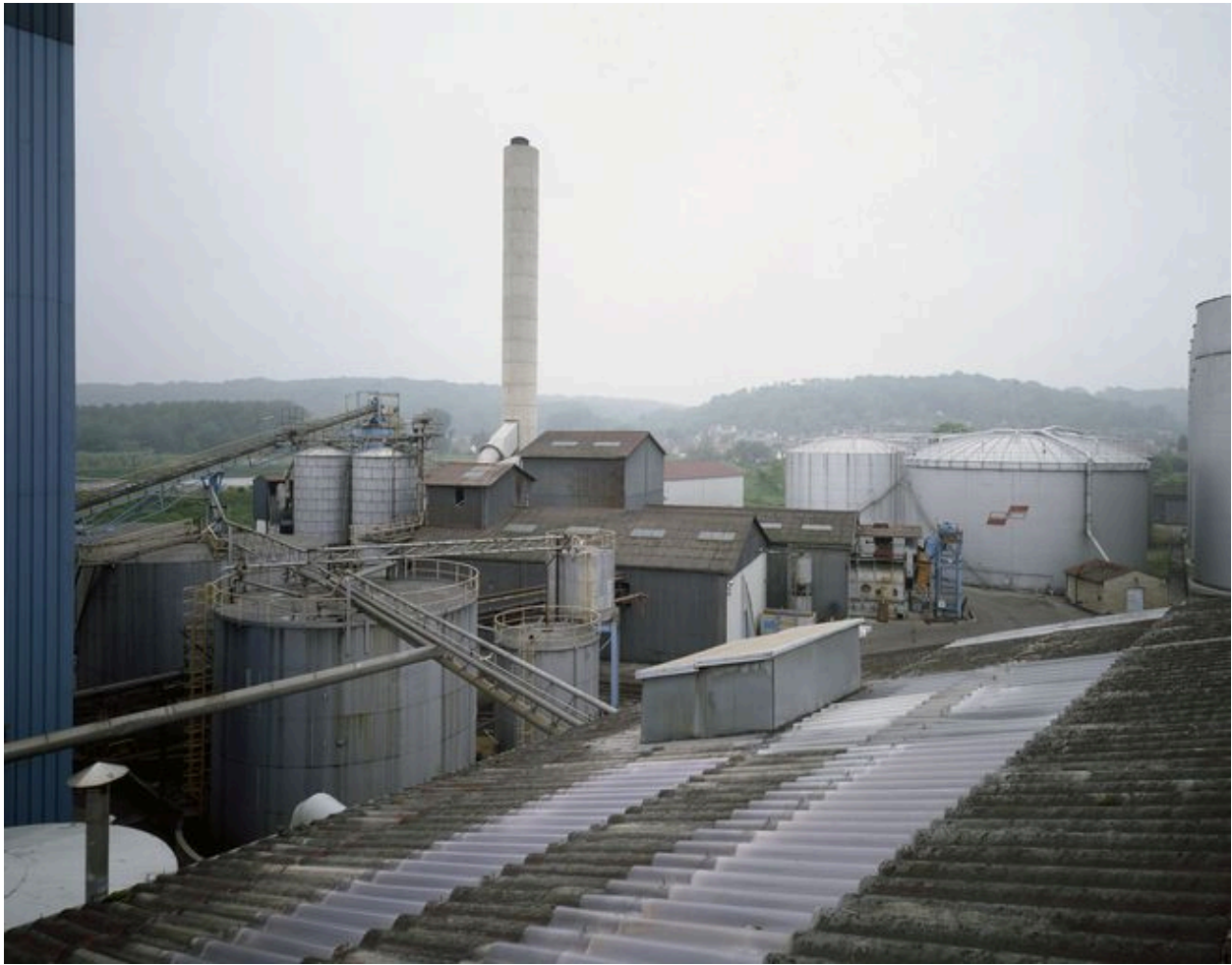
Ateliers de fabrication : vue générale.
