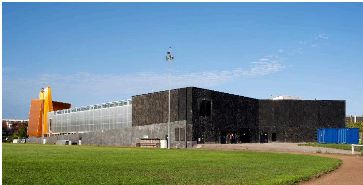
Façades arrière (nord) et façade sur bassins (est).
