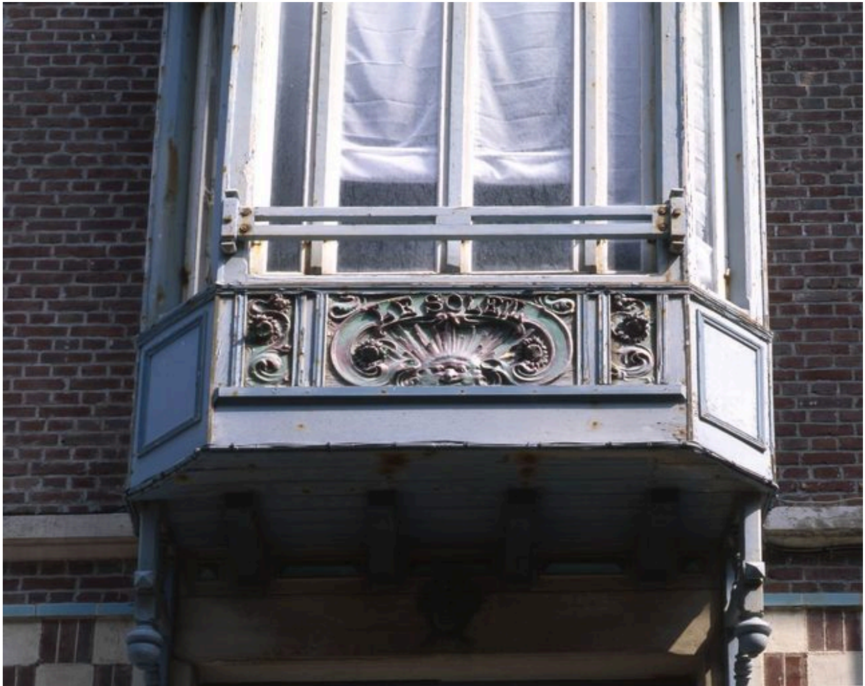
Détail du détail de céramique porté sur le bow-window du logement dit le Soleil.
