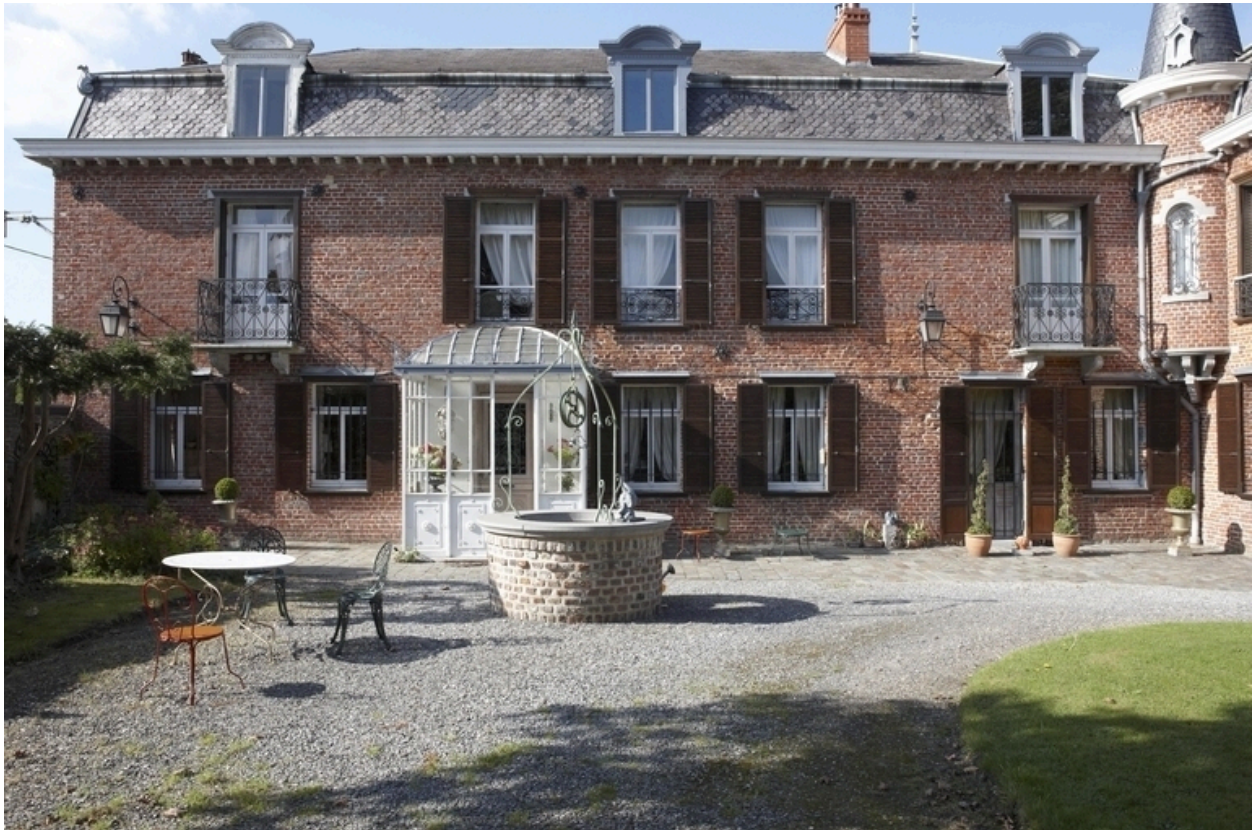
Vue du bâtiment surélevé.
