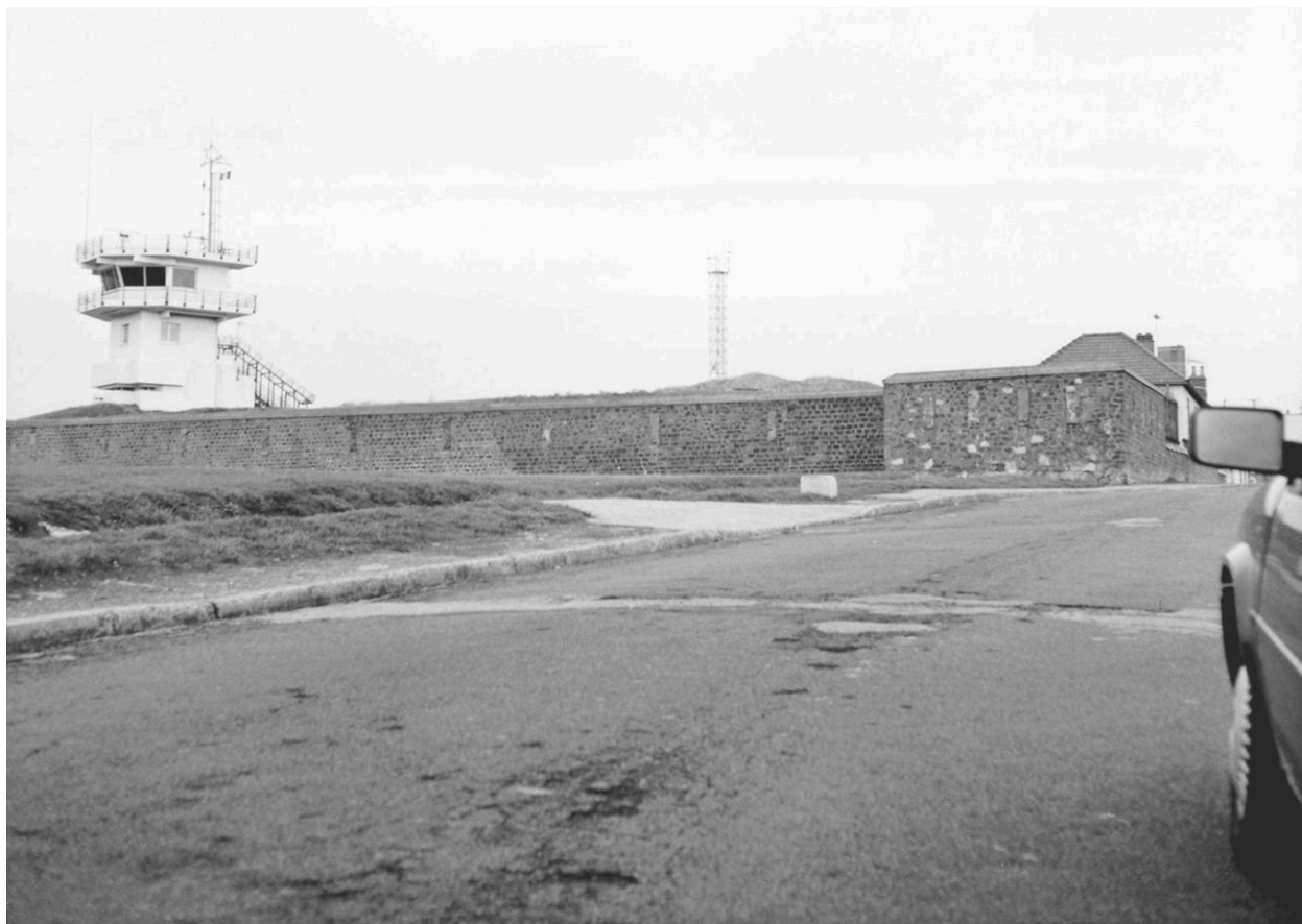
Façade partielle ouest.
