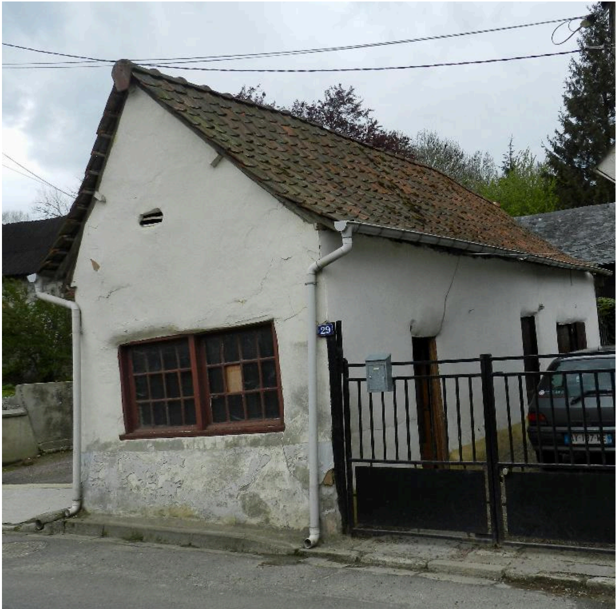
Atelier de serrurerie, rue de Bas.
