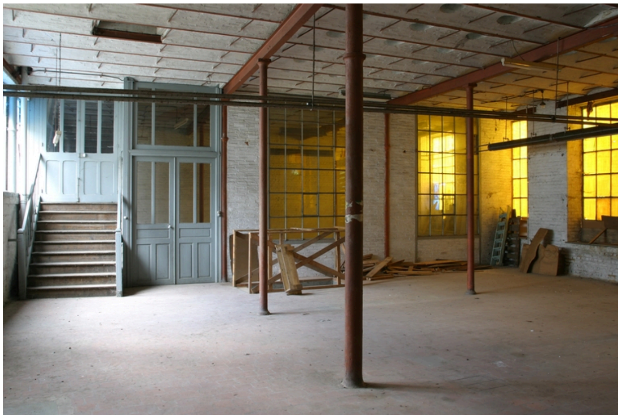
Rez-de-chaussée de l'atelier de 1900.
