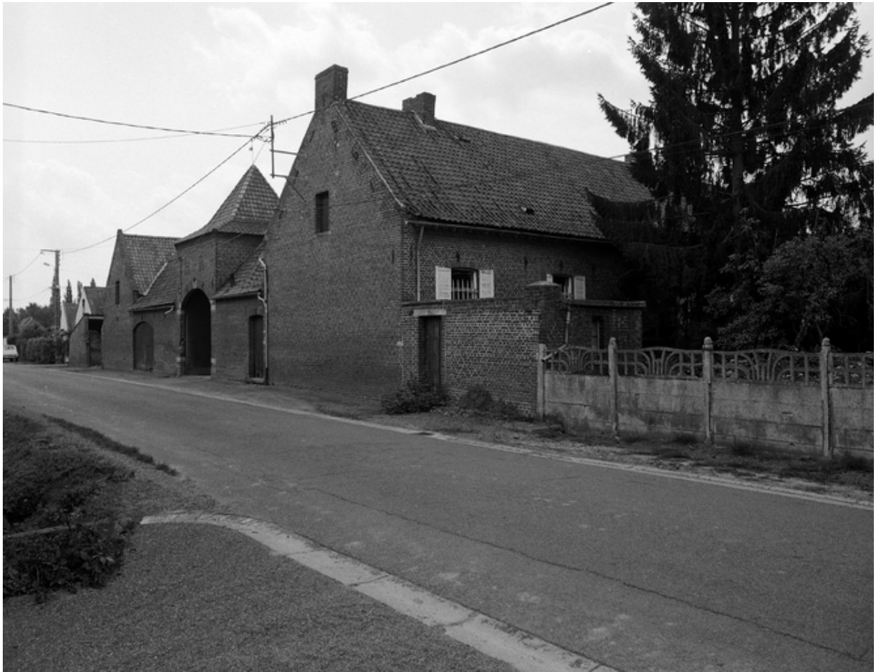
Vue générale de la ferme, 1036 rue de la Quièze.
