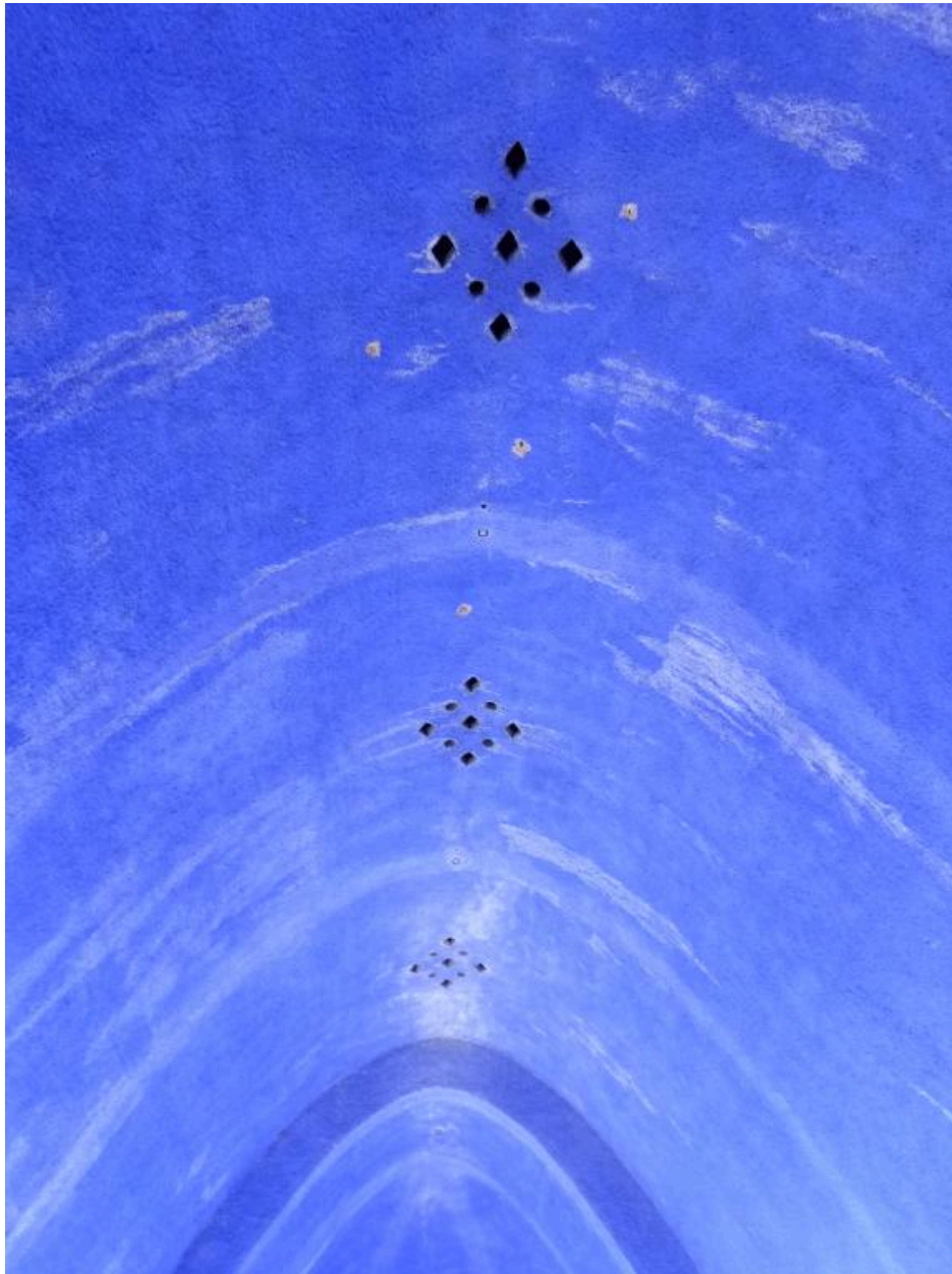
Détail de la voûte.
