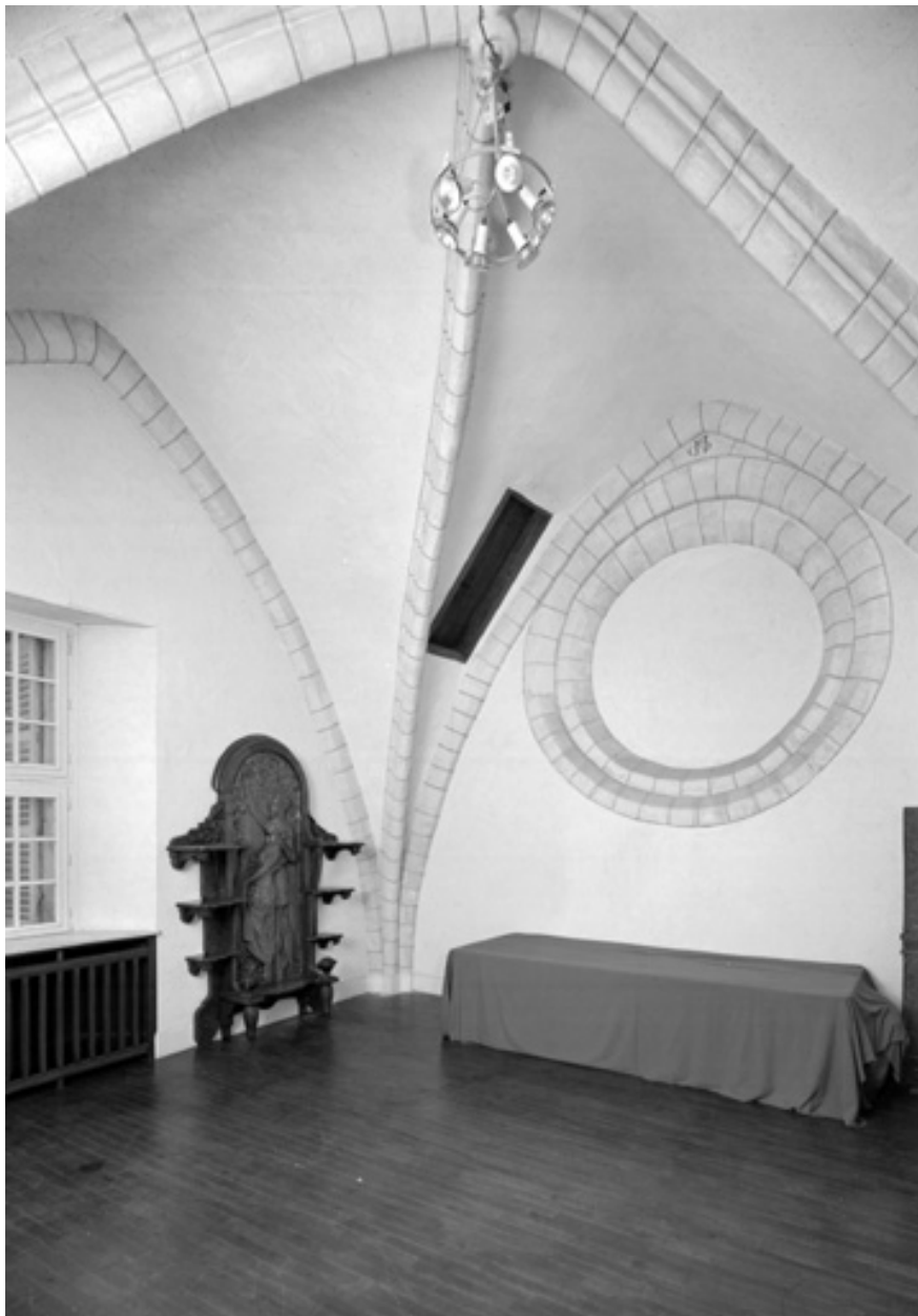
Le voûtement de la première travée.
