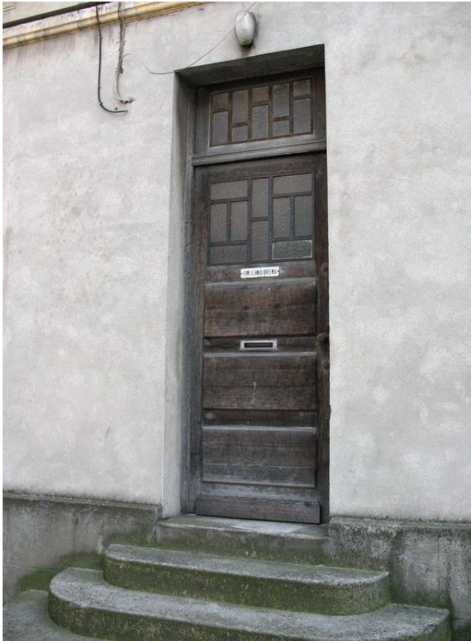
Porte d'entrée des bureaux.
