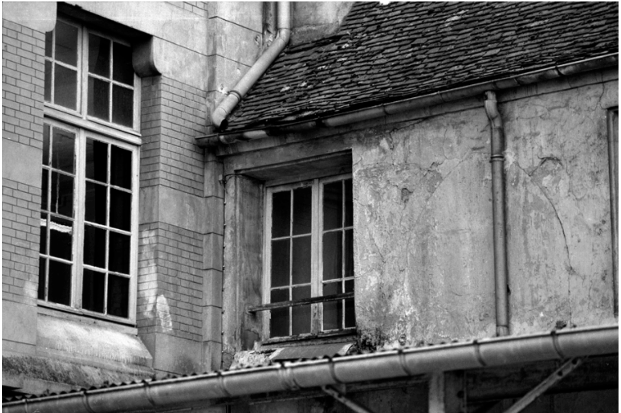
Détail du raccord entre le bâtiment neuf du XIXe siècle et de la chapelle.
