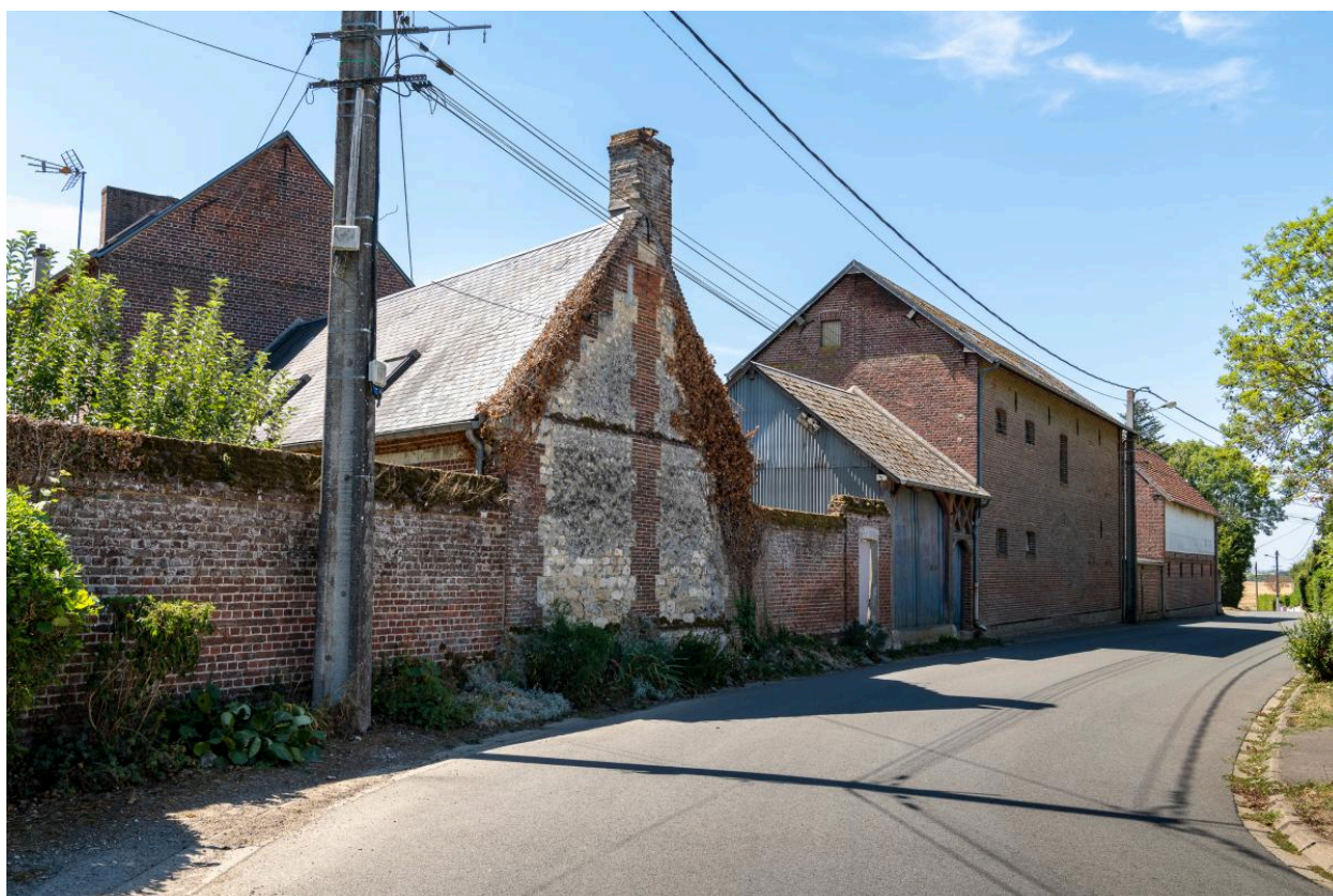
Ferme à cour, n°14 Grande Rue, vue depuis le nord-est.
