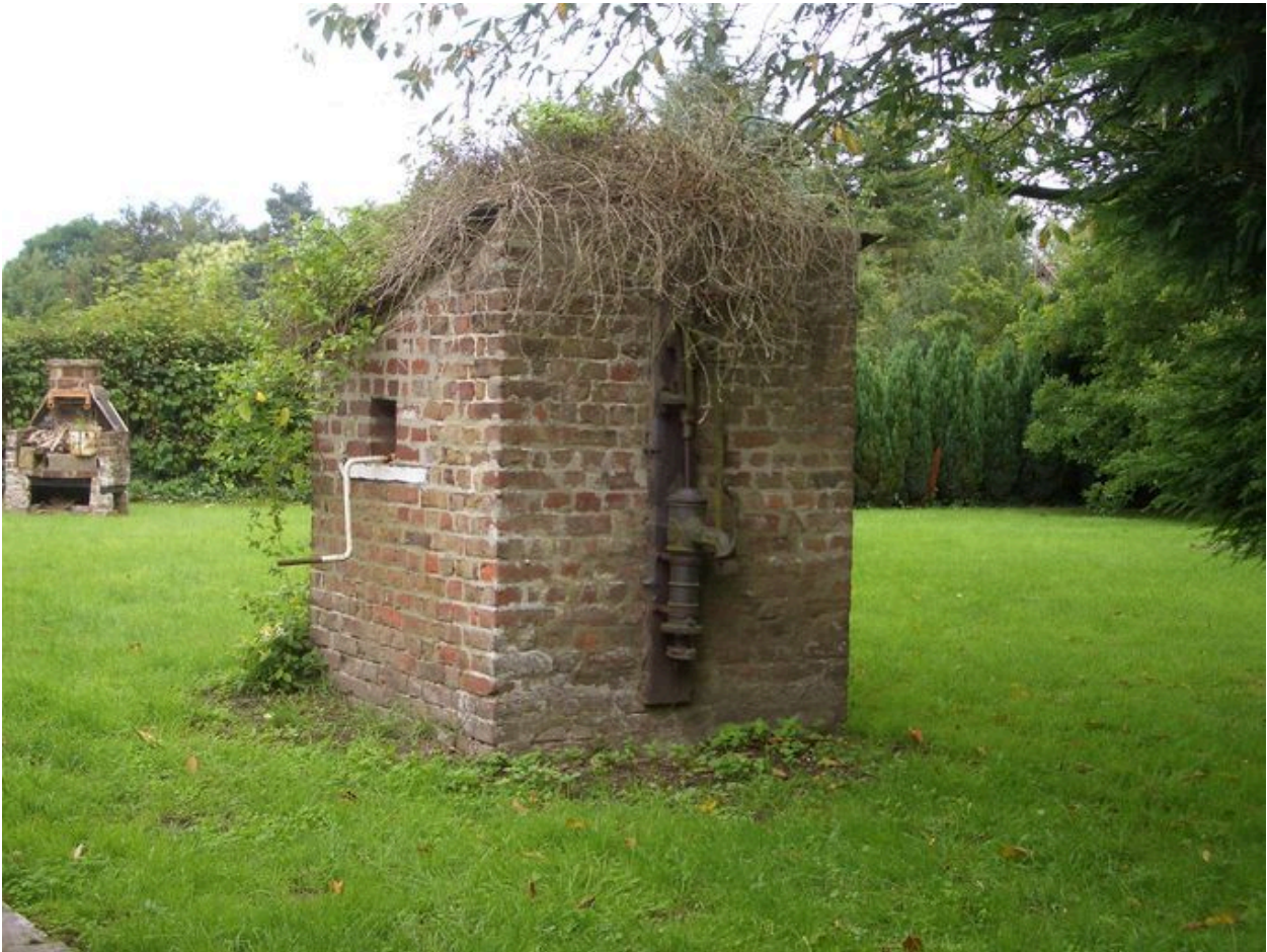
Vue du puits.
