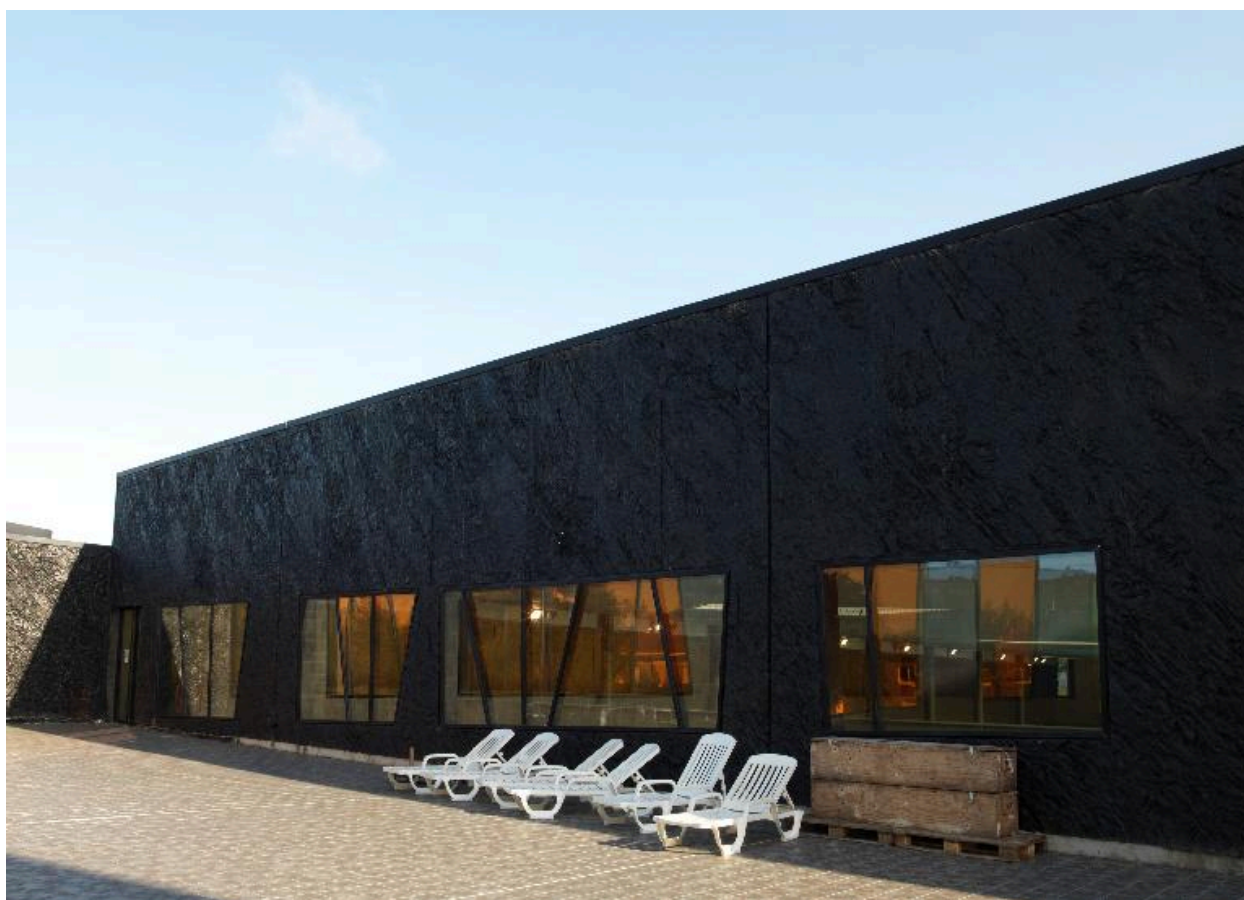
Terrasse-solarium, vue de la paroi donnant sur les bassins.
