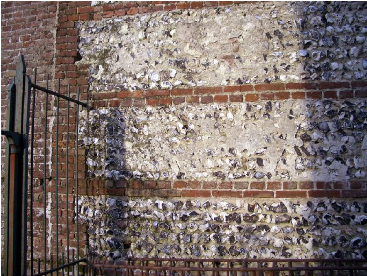
Détail de l'appareillage du pigeonnier.
