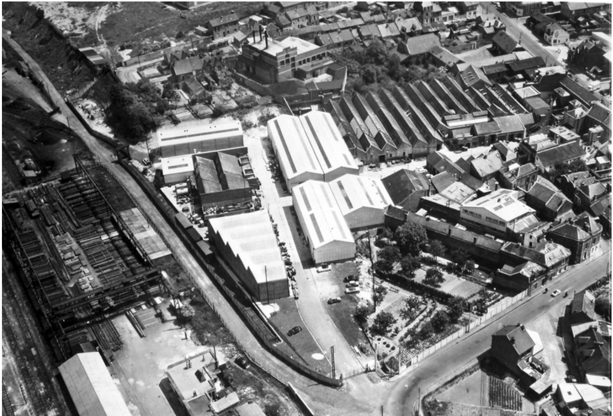
Vue aérienne en 1961-1962 (AD Aisne).
