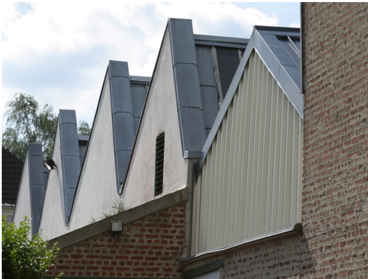
Les ateliers, couverts de sheds.
