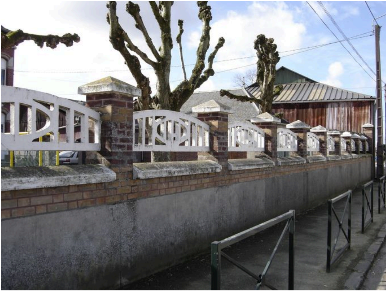
Vue de la clôture d'enceinte.
