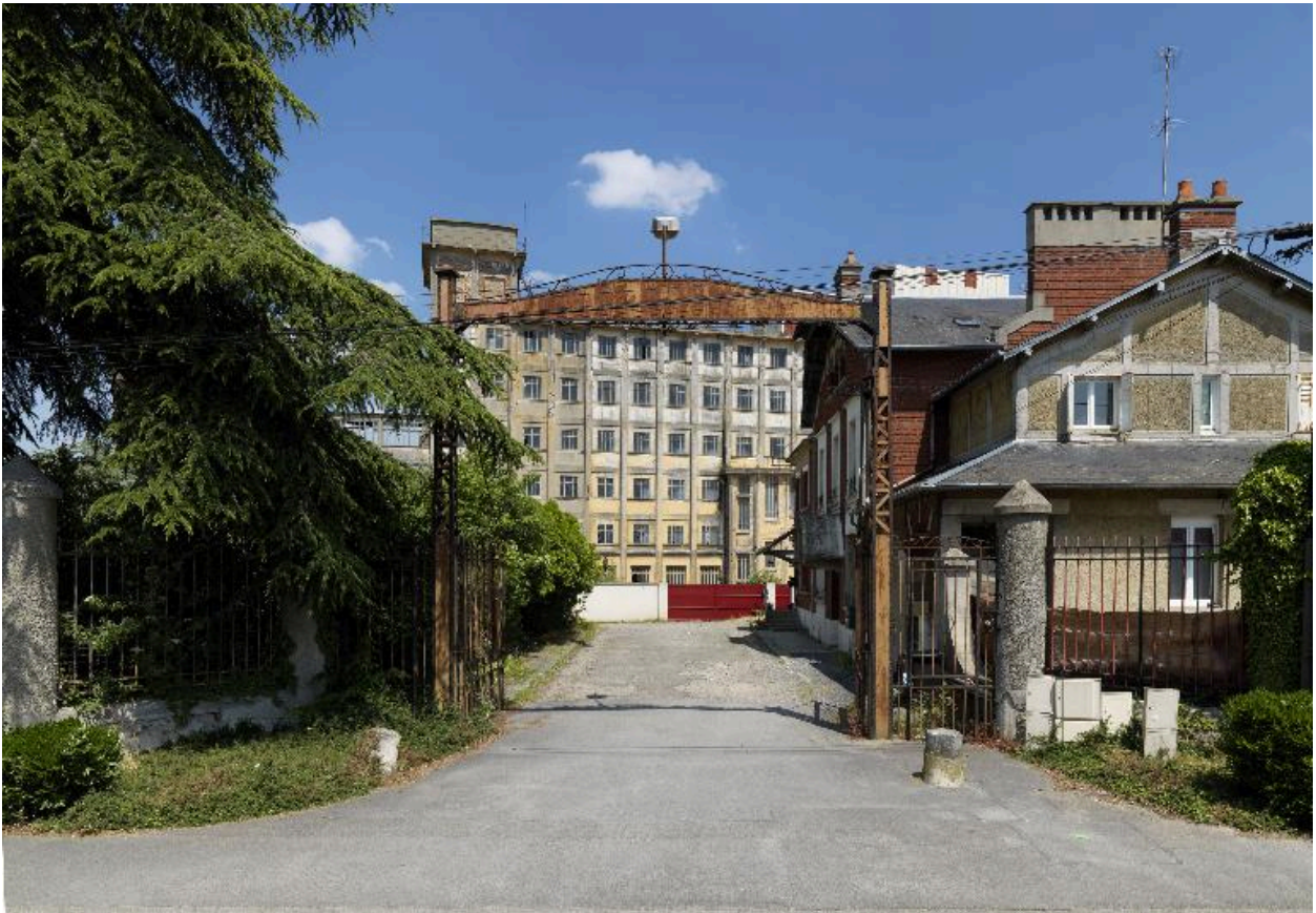
Entrée de la minoterie.
