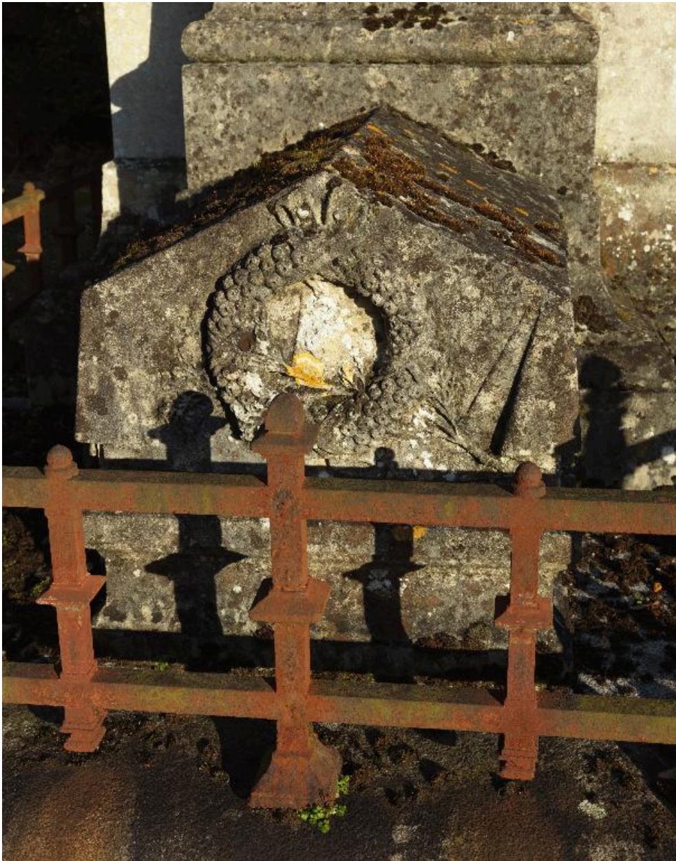
Monument sépulcral d'Edouard Gand, vue de détail sur la partie inférieure : tombale en forme de catafalque.
