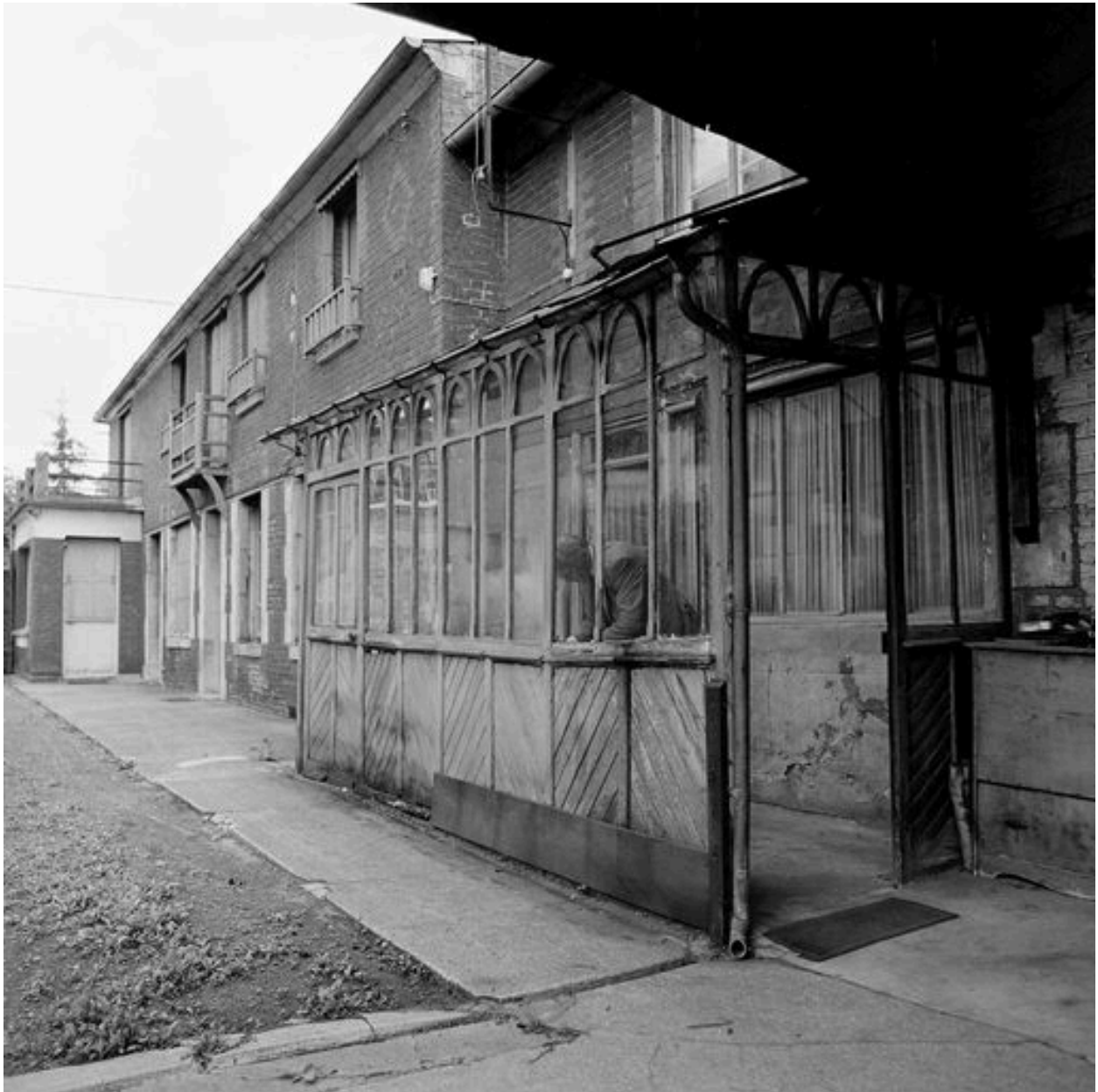
Logement patronal et bureau : détail de la véranda.
