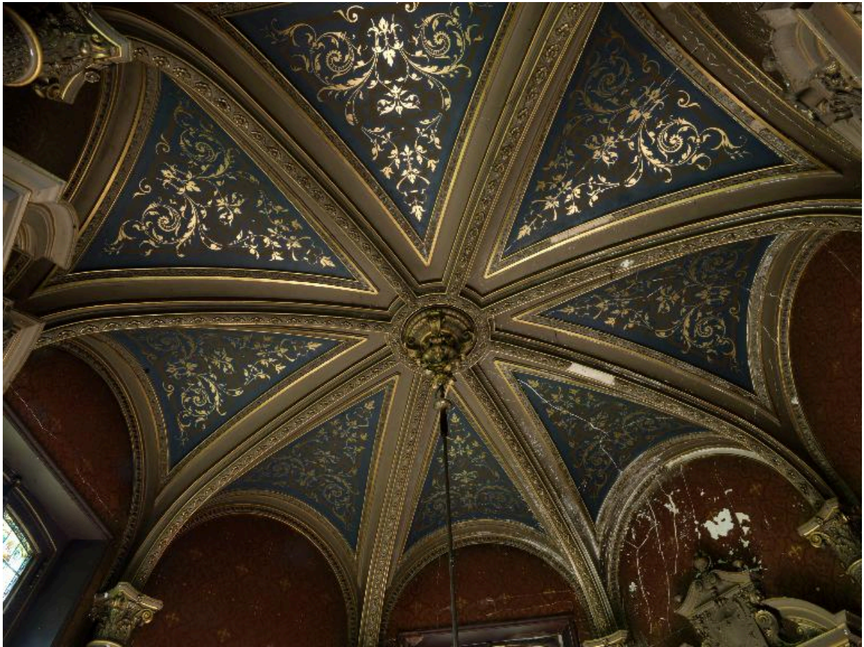
Plafond voûté du fumoir.
