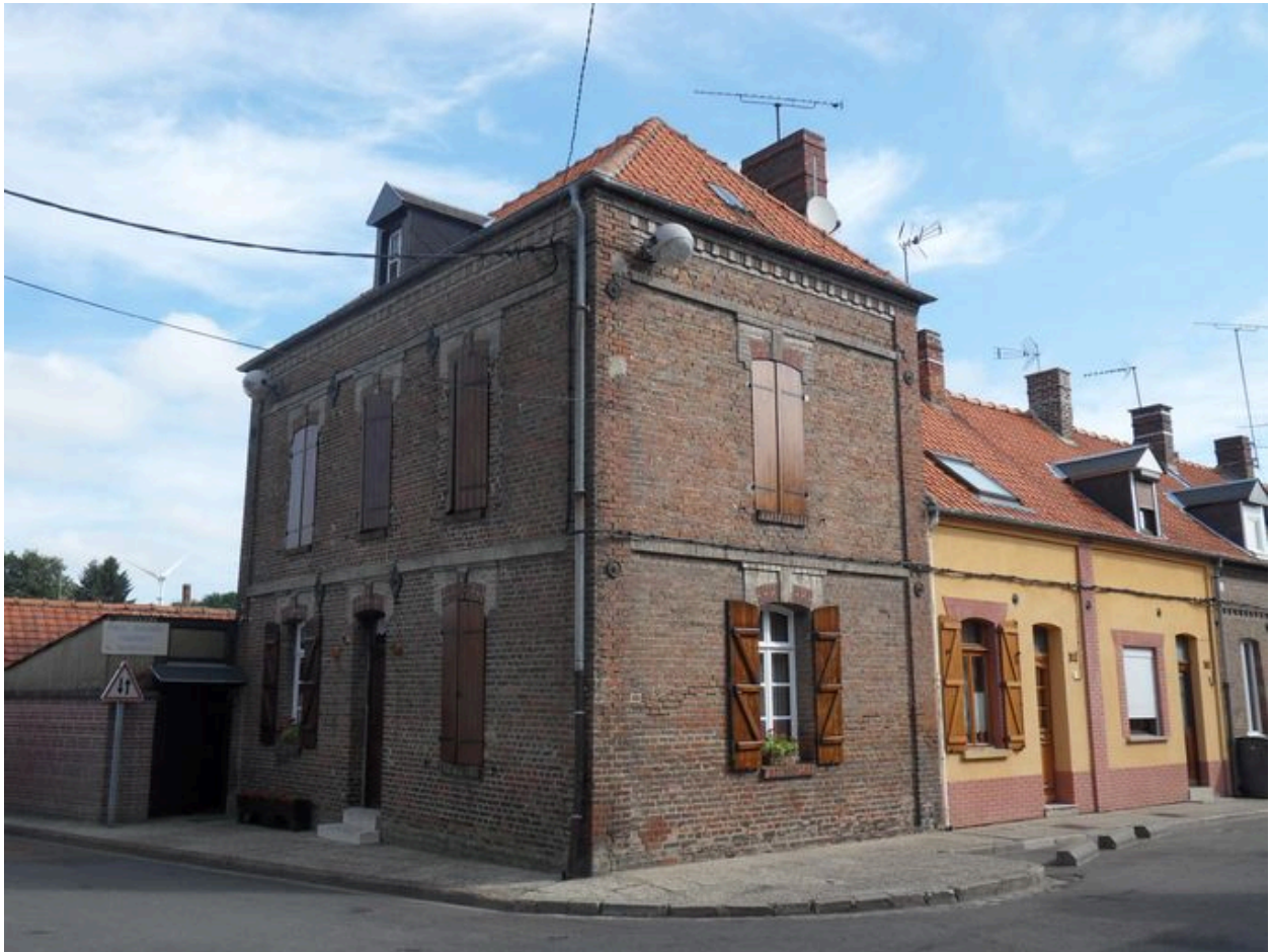
Maison de contremaître, 81 rue Docteur-Jean-Martin.
