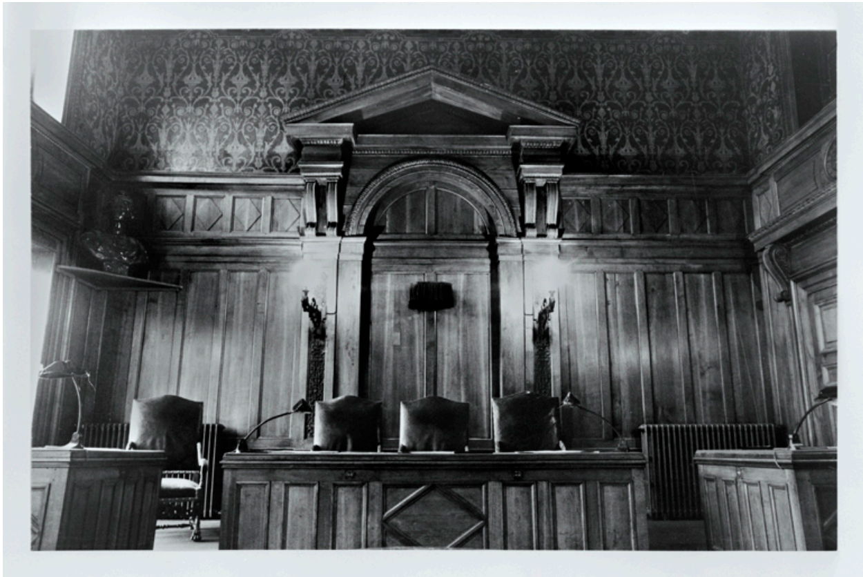
Détail de la tribune et des boiseries de la salle d'audience en 1976 (cliché CRMH).
